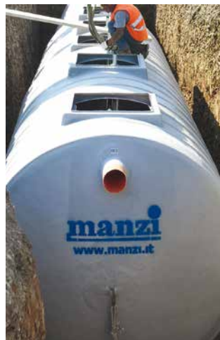
5. La posa in opera della vasca di accumulo in galleria
