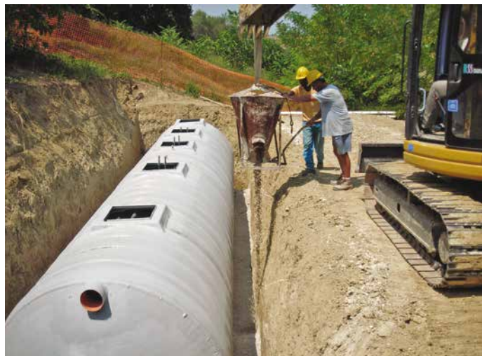
4. La posa in opera della vasca di prima pioggia
