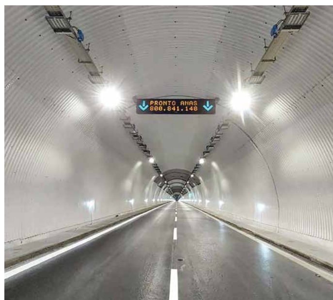
7. Un'immagine della galleria Montecoronaro al suo interno
