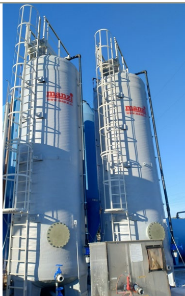
4. Autostrade per l'Italia: realizzazione di serbatoi verticali per cloruro di calcio (35 m 3 )
