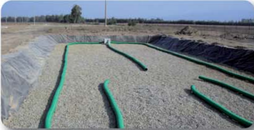
Evapotraspirazione in opera per 300AE, Comune, zona PIP - Sardegna Evapotranspiration plant for 300PE, Municipality - Sardinia
